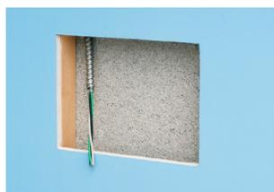
1 Déterminez l'emplacement du boîtier. Coupez un orifice dans le mur.
