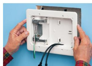
2 Tirez le tube métallique à travers l'orifice. Insérez le boîtier.
