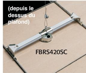
2 Placez la boîte au-dessus du trou. Placez les extrémités de la barre de support par-dessus l'ossature de plafond (tés).
