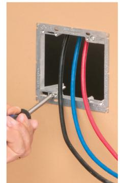
**4** Serrez les vis pour fixer solidement les ailes du support contre la cloison sèche.
