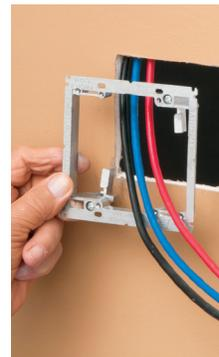
**3** Passez les fils. Insérez le support dans l'ouverture.
