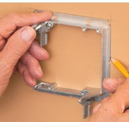
**Notre support** à un ou deux modules sert de gabarit de découpe. Mettez de niveau. Grâce à sa nouvelle conception, c'est plus facile que jamais! Tracez un point au crayon dans les encoches à chaque
