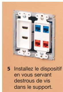
**5** Installez le dispositif en vous servant de vis dans le support.
