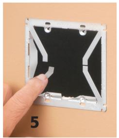
**5** Pliez les quatre supports de coin dans le trou et autour de la cloison sèche pour fixer solidement le LV1S dans l'ouverture.
