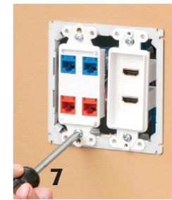
**7** Installez le dispositif en utilisant les trous de vis du support.
