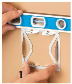
**1** Le support sert de gabarit pour l'ouverture. Placez le support face vers le bas sur la surface. Mettez de niveau.
