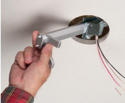
1 Déterminez l'emplacement du ventilateur/ luminaire. Découpez un trou de 10,31 cm de diamètre dans le plafond. Retirez la boîte (uniquement) du support. Desserrez les vis de la glissière pour permettre de centrer au-dessus du trou (étape 5). Insérez le support dans l'ouverture.
