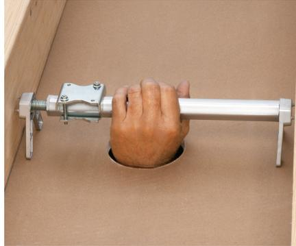
2 Placez le support entre les solives avec les « pieds » reposant sur le plafond. Encastrez les extrémités du support dans les solives en tournant la barre hexagonale manuellement...
