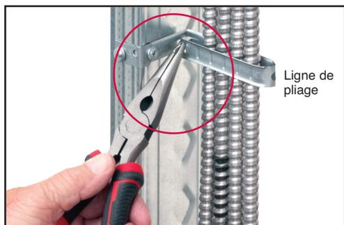
3 Pliez la languette par-dessus le support pour verrouiller le câble solidement en place. Le CUS6 peut maintenir jusqu'à quatre câbles MC ou six câbles NM centrés sur un montant de 5x10.
