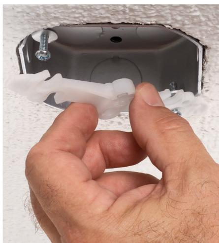
1 Fixez le support sur la boîte à l'aide de vis n° 8 ou n° 10. Faites ressortir les vis juste assez de la boîte pour enfiler le support.
