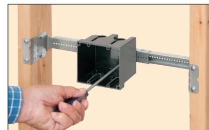
Installez la(les) boîte(s) en plastique ou en métal sur la SliderBar avec des vis à tôle n° 8.
